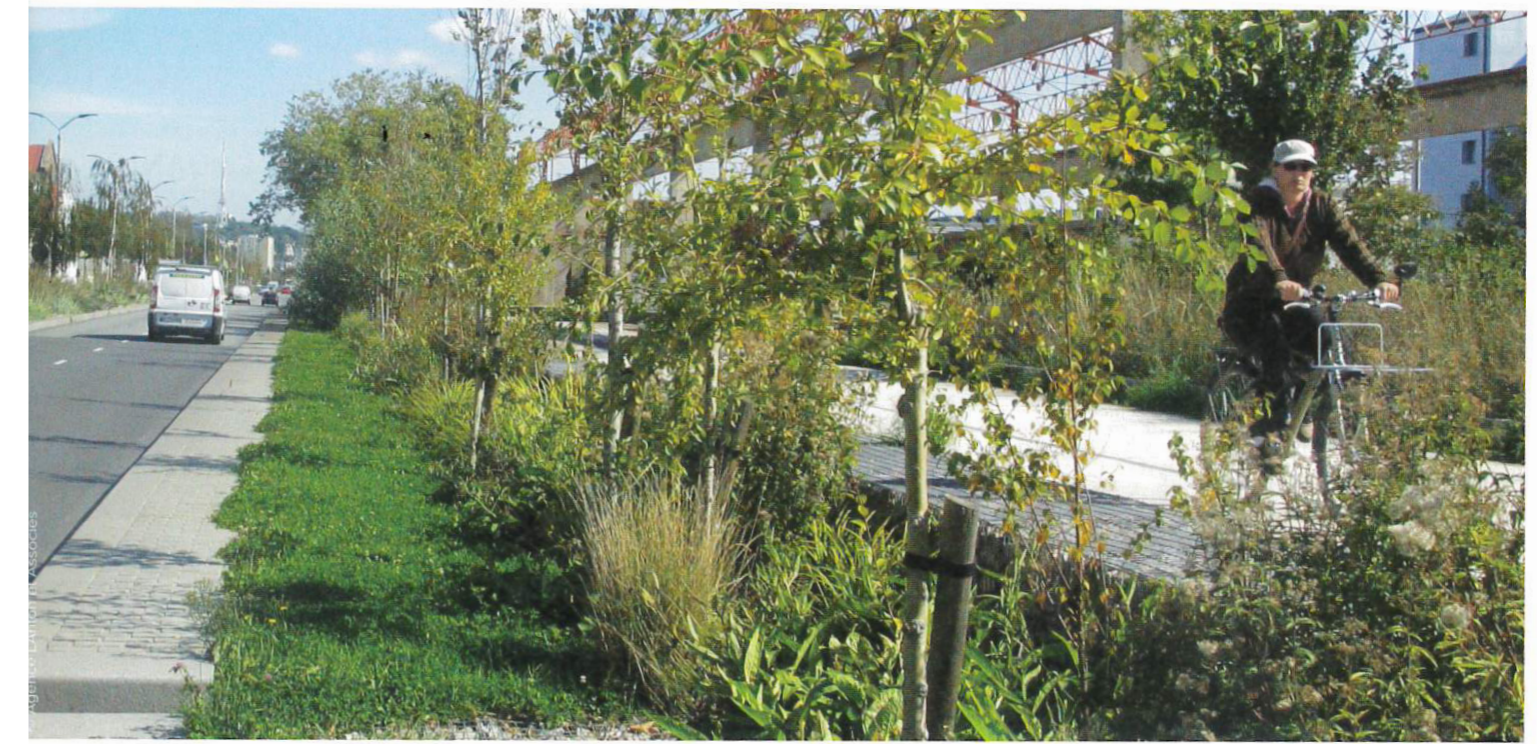
Saules, aulnes glutineux, ormes blancs, fétuques, iris des marais, salicaires... les noues sublatales, de 3 m de large, accueillent une végétation "sauvage", typique des fossés de plaines alluviales.
