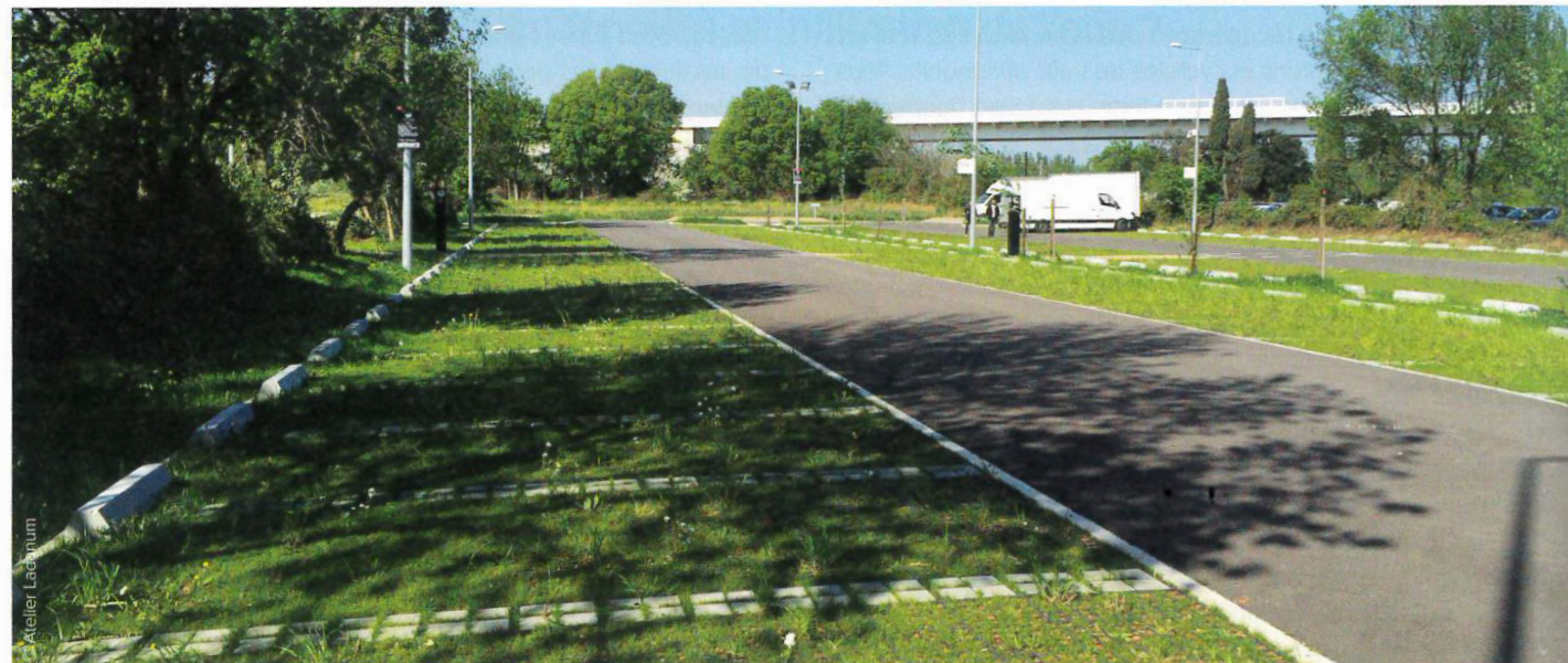
Dans une logique d'infiltration à la parcelle, les stationnements ont été réalisés selon le procédé Ecovegetal Mousses, adapté à un usage intensif. Les semences intégrées au substrat favorisent l'installation progressive d'une végétation extensive rasante et résistante.
