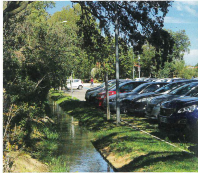
L'eau pluviale infiltrée sur les stationnements est récupérée par un réseau de noues étanchées qui acheminent tout doucement l'eau vers un bassin d'infiltration. Un lit d'argile totalement étanche a été créé à - 40 cm, à partir des matériaux du sol présents sur place.
