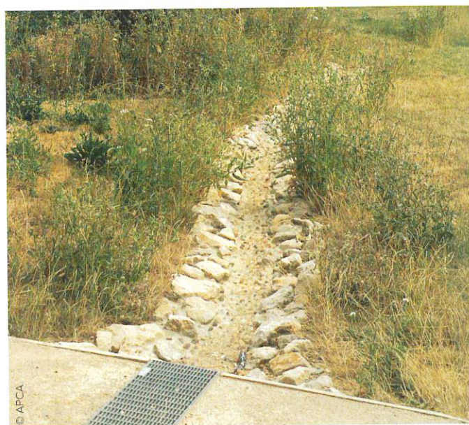
Des "canaux" en galets de Moselle acheminent l'eau depuis le pied des façades jusqu'à des espaces en creux situés en points bas. Un chemin de l'eau conçu pour gérer les eaux pluviales du site à la parcelle.
