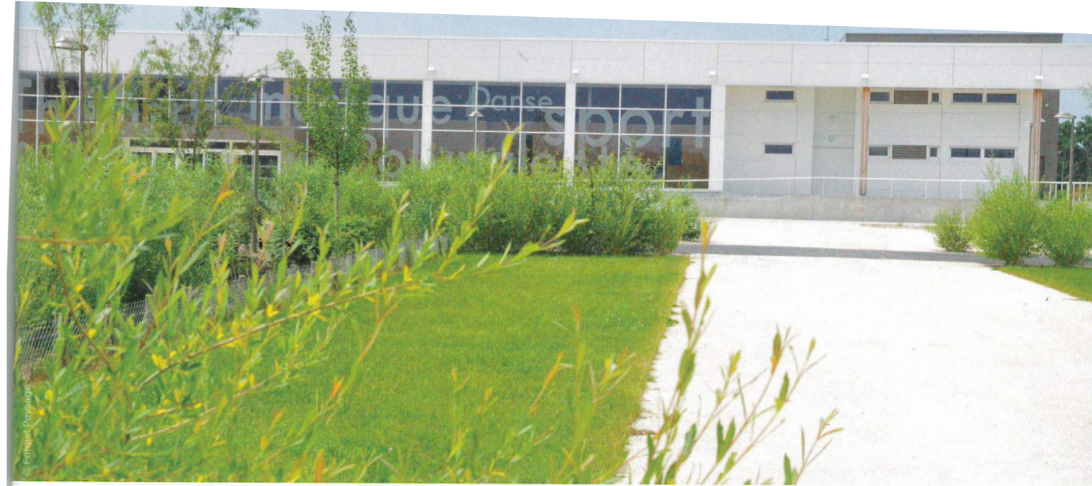
Pour gérer les eaux pluviales en surface, sans rejet au réseau, 200 places enherbées, installées sur un mélange terre-pierre réutilisant les terres en place, offrent un stationnement temporaire, en complément de 50 places en stabilisé renforcé à proximité de la salle polyvalente.
