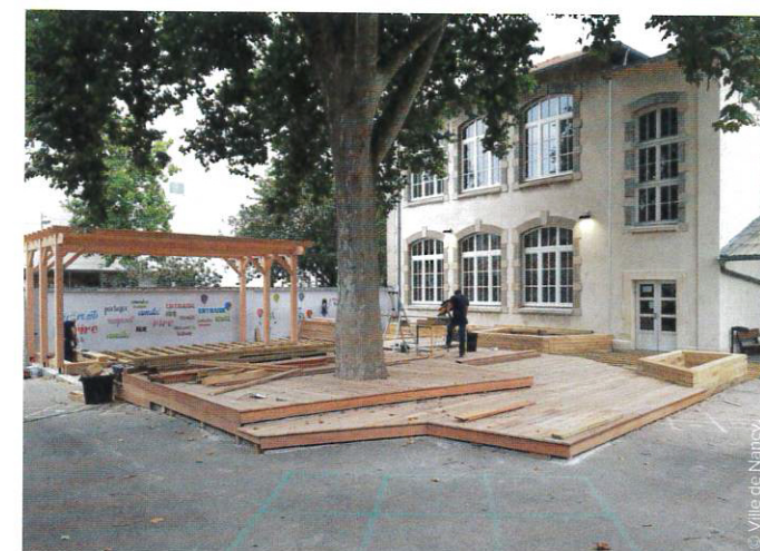
Platelage bois sous le platane de la cour d'école Saint-Georges Au niveau de l'école Saint-Georges, où la cour est de petite taille par rapport au nombre d'élèves, un grand platelage bois a été mis en œuvre au pied du vieux platane remarquable. Avec plusieurs niveaux pour s'asseoir ou grimper, il protège la surface de pleine terre sous-jacente, permettant à l'arbre (et à la cour !) de mieux respirer.
