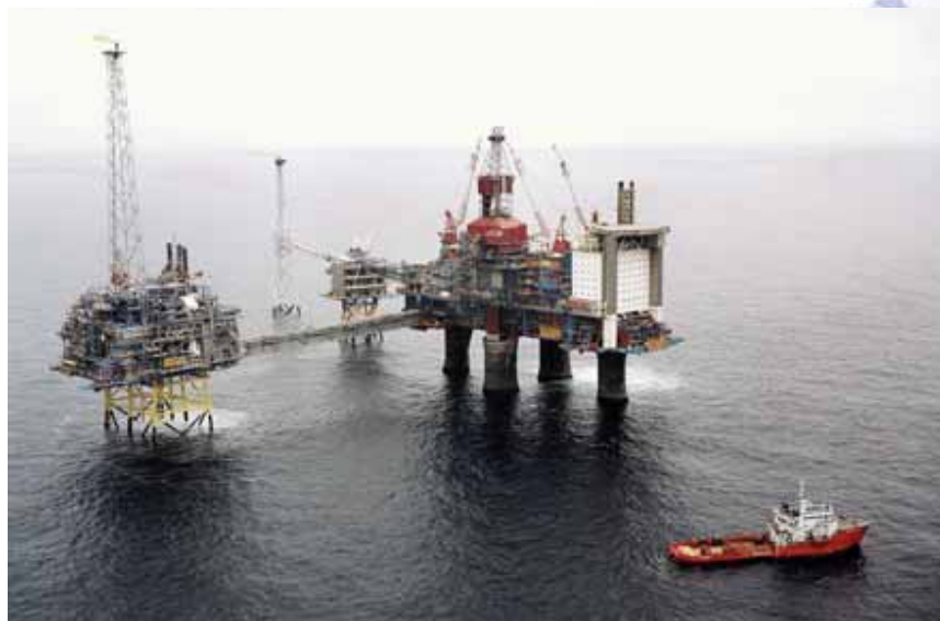
Plate-forme de Sleipner en mer du Nord (Norvège) pour la production de gaz naturel avec séparation du CO 2 qui est réinjecté dans un aquifère salin.
