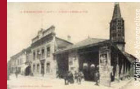
La halle, adossée à la mairie
