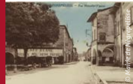
Un couvert existait au droit de la boulangerie
